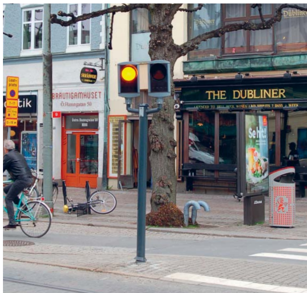
Bild 10. Gul blinkande signal tänds när spårvagn eller buss närmar sig
