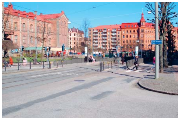
Bild 14. Prinsgatans spårövergång från söder
