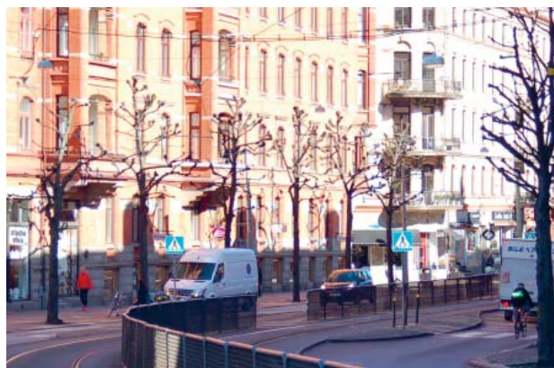
Bild 16. Övergången ligger i en kurva vilket försämrar sikten
